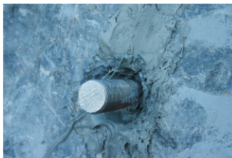
Im Fels versetzte Ankerhülse mit Ankerstange
