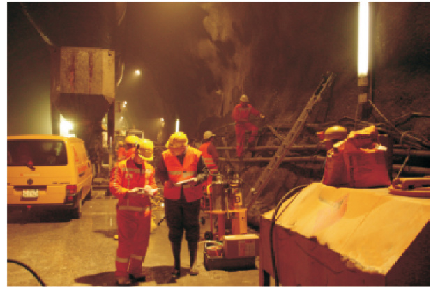
Ingenieure und Prüfer an der Arbeit
