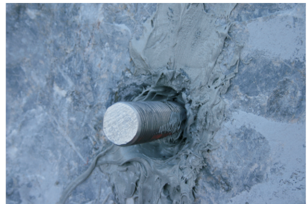
Im Fels versetzte Ankerhülse mit Ankerstange
